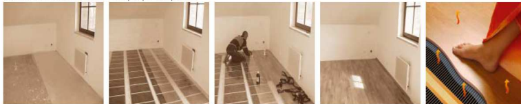
Ilustrační foto montáže ECOFILM F608 pod plovoucí podlahou
